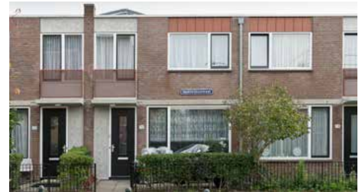
Renovatie Naaldwijksestraat Den Haag met unieke Mussenpanelen.
